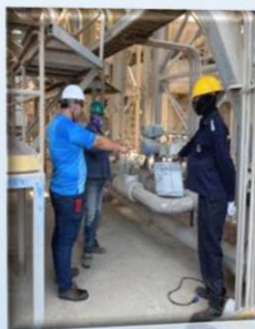
งานแก้ไขท่อ flasher Boiler SP5 รั่ว
