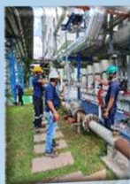
งานเปลี่ยน Valve steam trap main header
