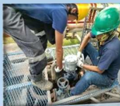
งานเปลี่ยน Valve steam trap main header
