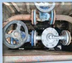
งานเปลี่ยน Valve steam trap main header
