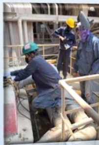
งานแก้ไขท่อ flasher Boiler SP5 รั่ว
